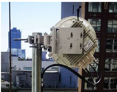
方向調整し易い取付金具 (1ftアンテナ+耐塩金具の例)
