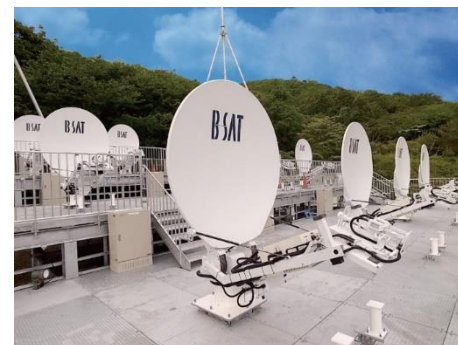
衛星放送バックアップ局アンテナ
